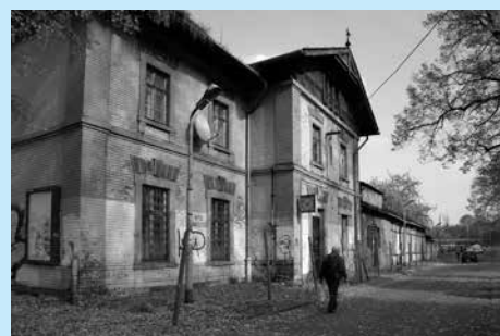
Konkursowa koncepcja ma m.in. zakładać rewitalizację obiektu budynku dworca PKP.
